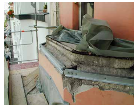
Nach Grundsanierung wieder nutzbar: Balkonabriss und -wiederaufbau
