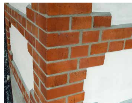
Nach der fachgerechten Sanierung präsentiert sich die Fassade in neuer Optik
